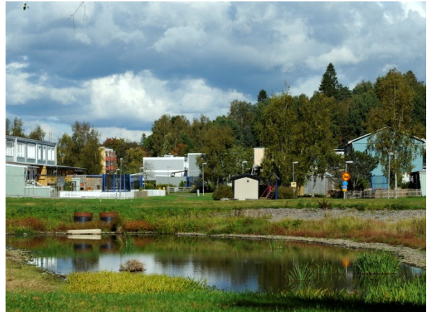
Fördröjningsdamm i Röda dalen, Nol.
